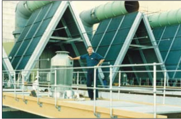
Prof Kröger op die waaiplatform van 'n kragstasie se lugverkoelde kondensator.
